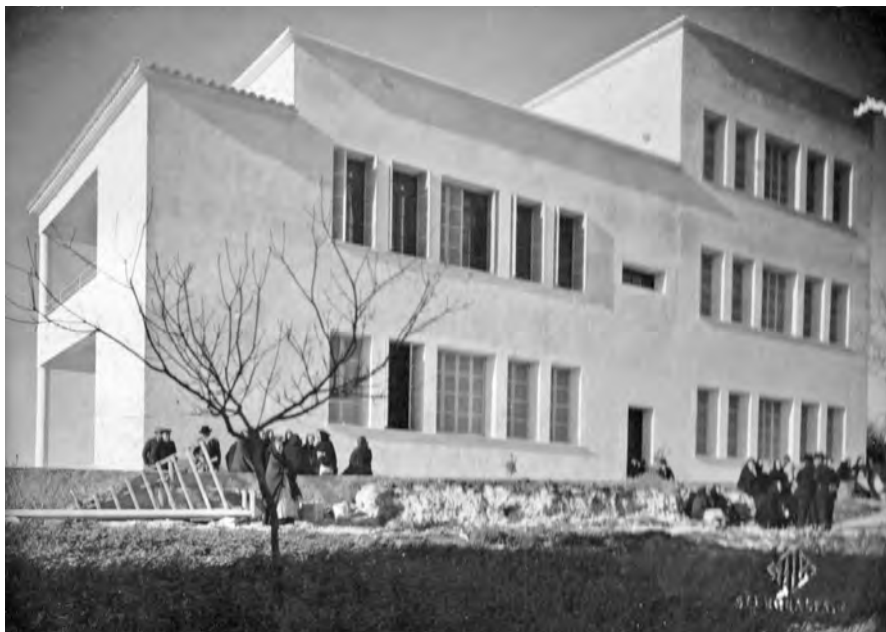
Grup Escolar de Montuïri, de l'arquitecte Guillem Forteza, inaugurat el 1935 durant el mandat del batle republicà Joan Mas i Vert, Collet .
